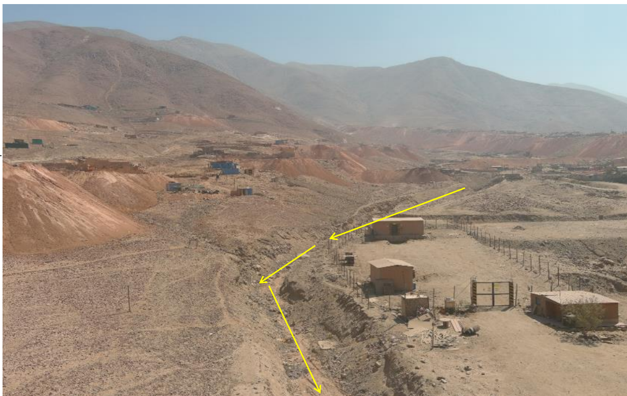
FIGURA N°03: TRAMO CRITICO QUEBRADA SAN JUAN, SE VISUALIZA LA FALTA DE DESCOLMATACION Y LIMPIEZA DEL CAUCE.
